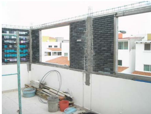
Figura 1 Sistema constructivo S.M.P.A.
