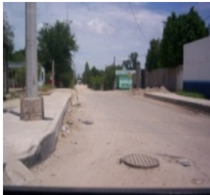
Ilustración 15 En San Pedro el Saucito ninguna calle o avenida está asfaltada
