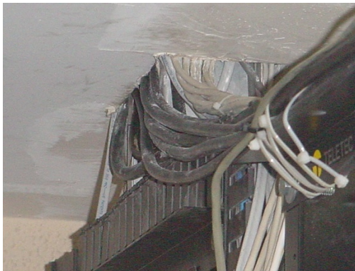
Fotografía 12 Saturación cables
